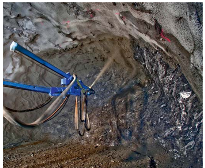
Auftrag der Spritzbetonsicherung
