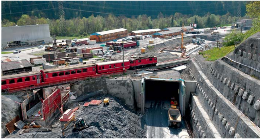
Hilfsbrücke für den Bahnbetrieb
