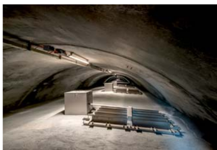
Abluftkanal über der Tunneldecke
