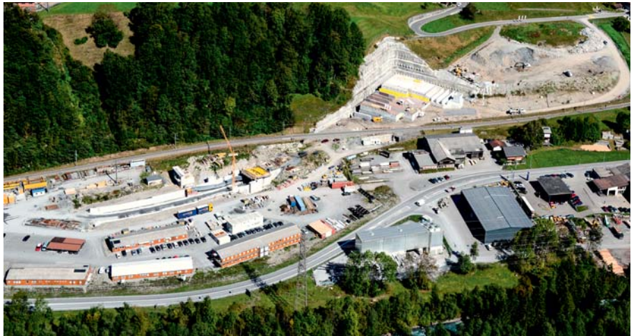
Rohbau Tunnelzentrale Dalvazza mit Tagbautunnel und Sicherheitsstollen
