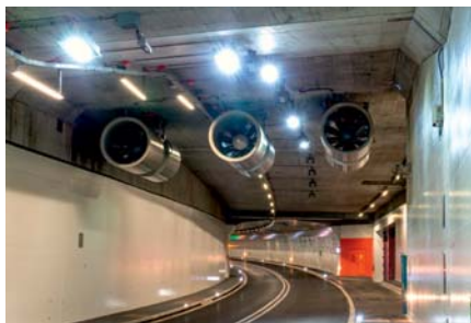
Führungsbeleuchtung und Strahlventilatoren
