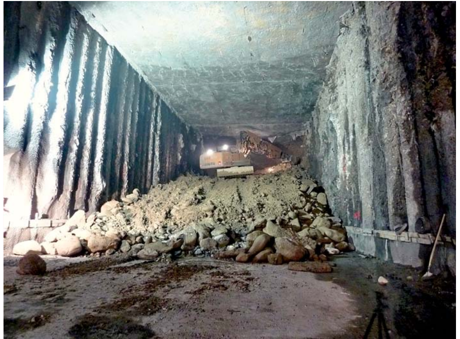
Deckelbauweise für die Querung Schanielatobel
