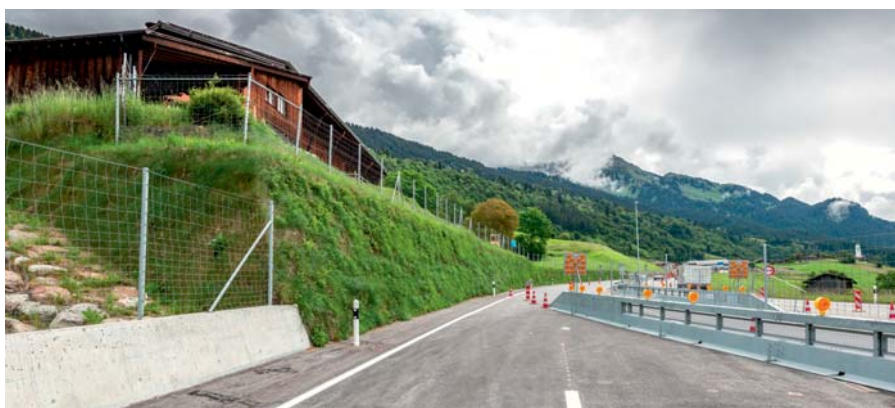
Erdbewehrte Stützkonstruktion als Lärmschutz
